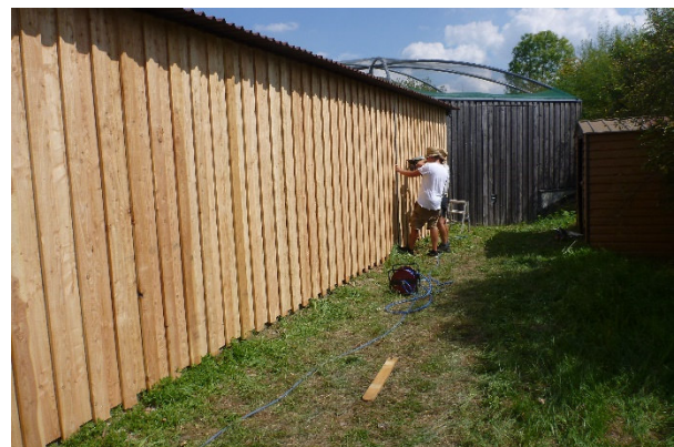
Sanierung der Rückwand einer Volierenanlage, finanziert durch die Deutsche Postcode Lotterie.
